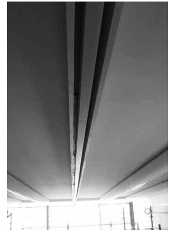
写-6 照明取付状況
