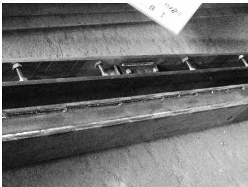
(a) 歪み防止仮設ボルト
